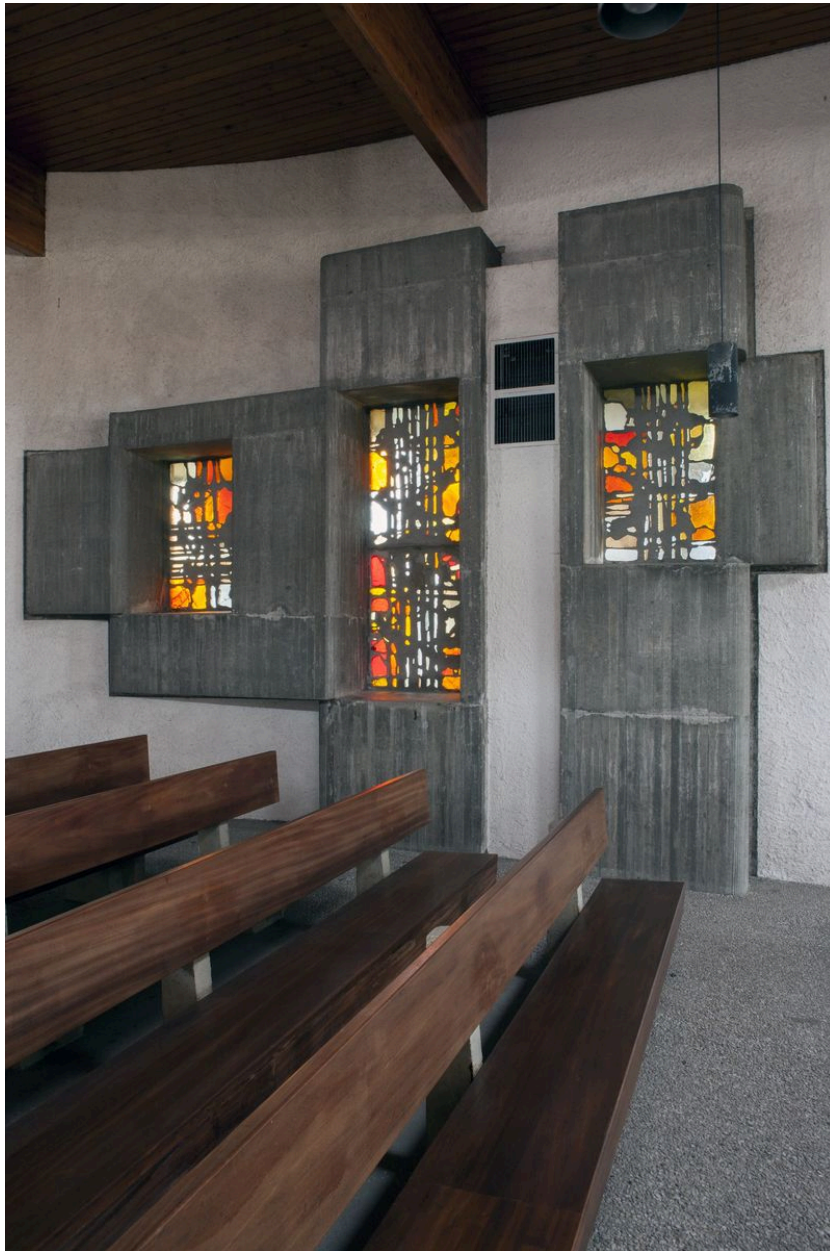
Vue intérieure de trois quart droit des verrières sur le flanc gauche.
