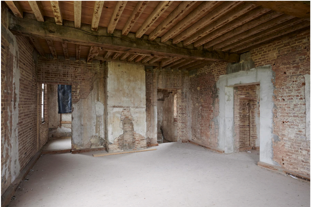
Premier étage. Logis XVIe siècle. Chambre. Vue vers la cheminée, le réduit et la cage d'escalier.
