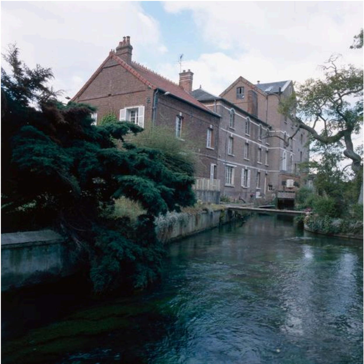
Vue d'ensemble postérieure depuis la rivière.
