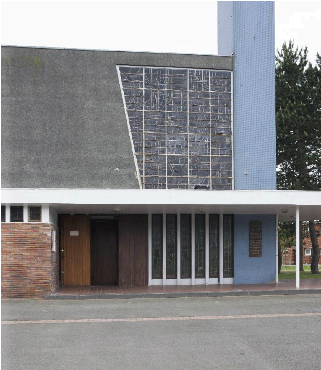
Vue de la partie centrale de la façade antérieure de l'église.
