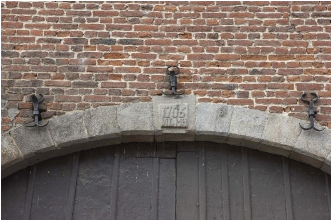
Détail de la date portée à l'entrée du porche.
