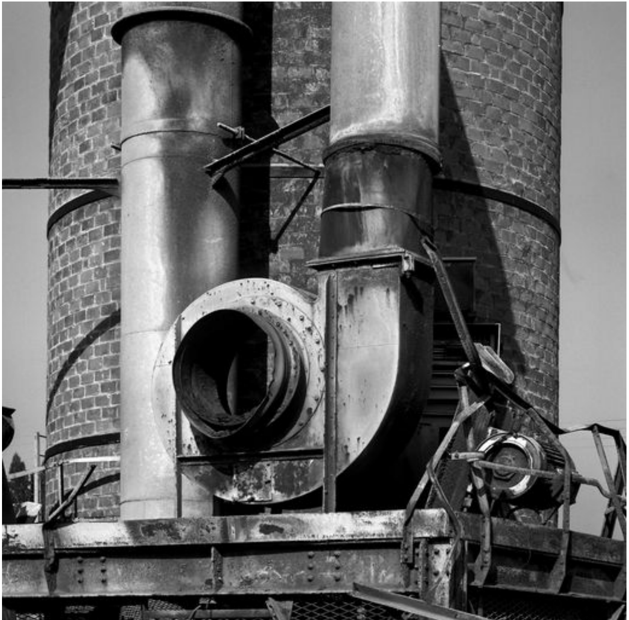
Ventilation de la cheminée.
