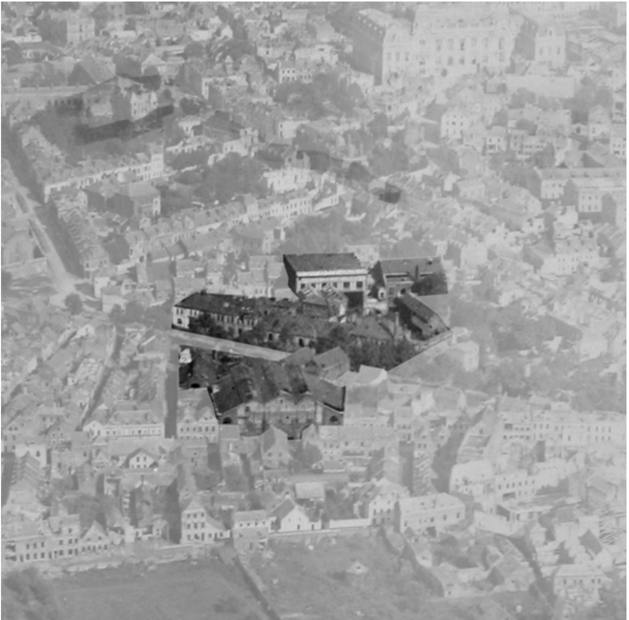
Vue aérienne de l'usine, 1918 (BM Saint-Quentin).
