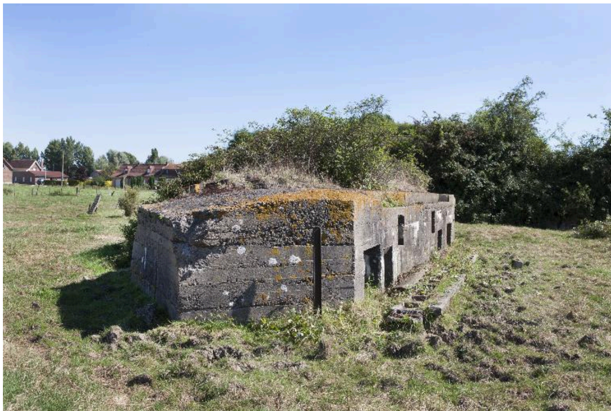
Vue générale vers le nord-est
