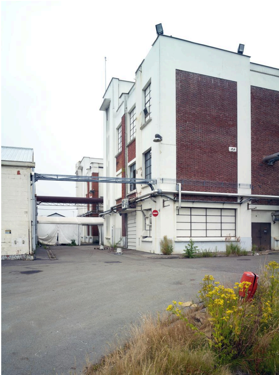
Pignons ouest des ateliers de fabrication (H et G), vers le nord-est.
