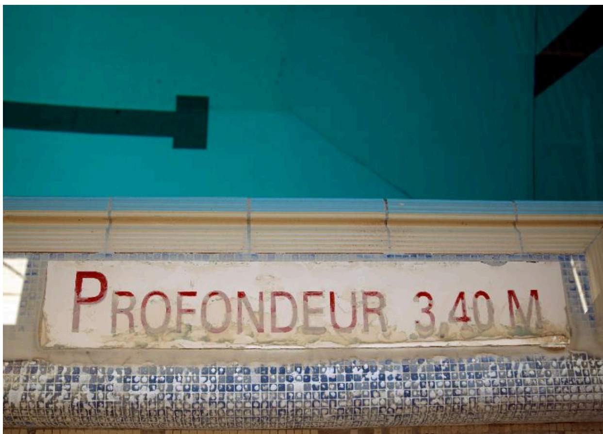
Détail de la margelle du grand bassin, profondeur maximale : 3,40 mètres.
