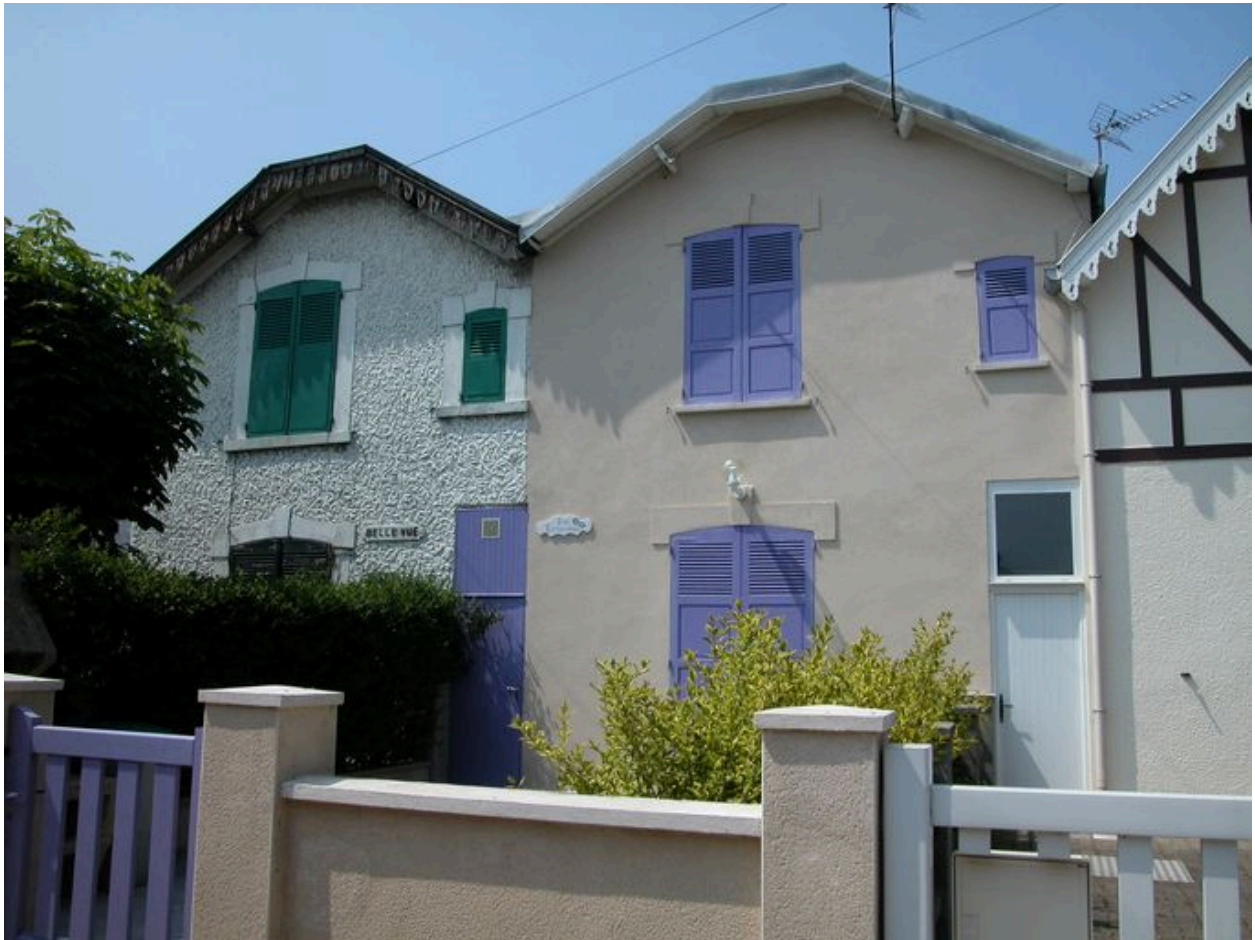
Détail de deux maisons.
