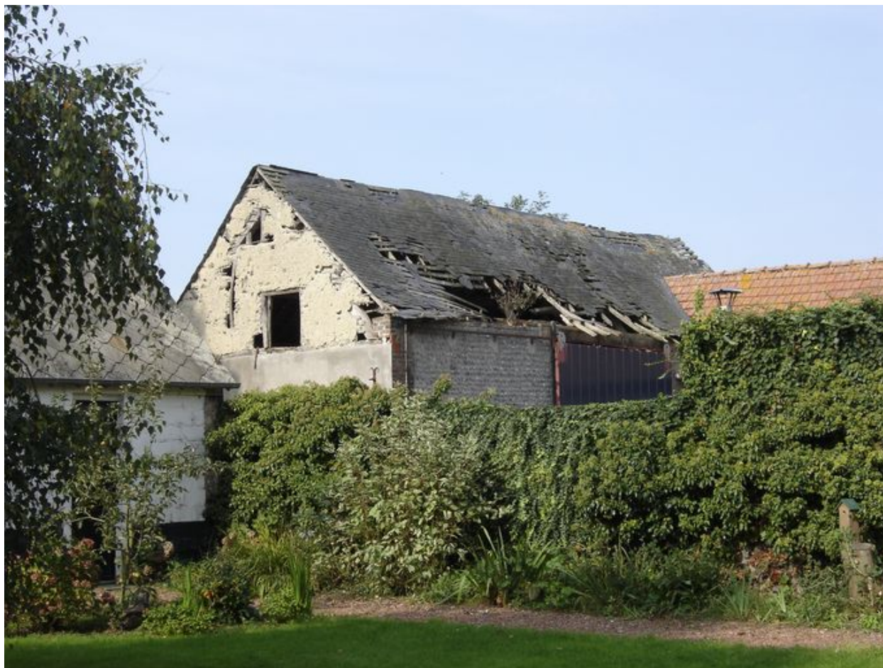
Vue latérale de la grange.
