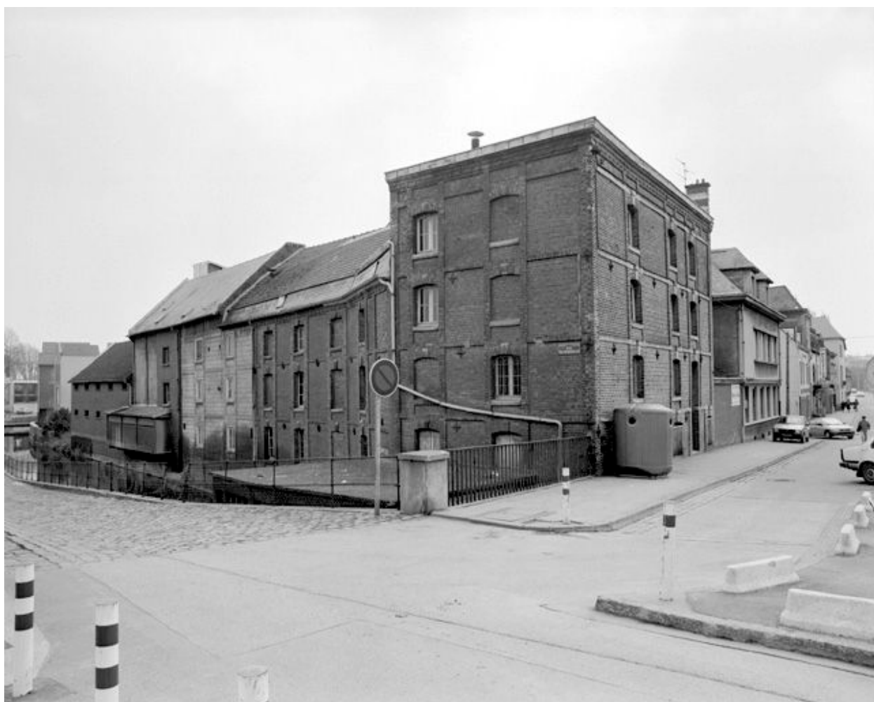
Vue générale, flanc nord-ouest.
