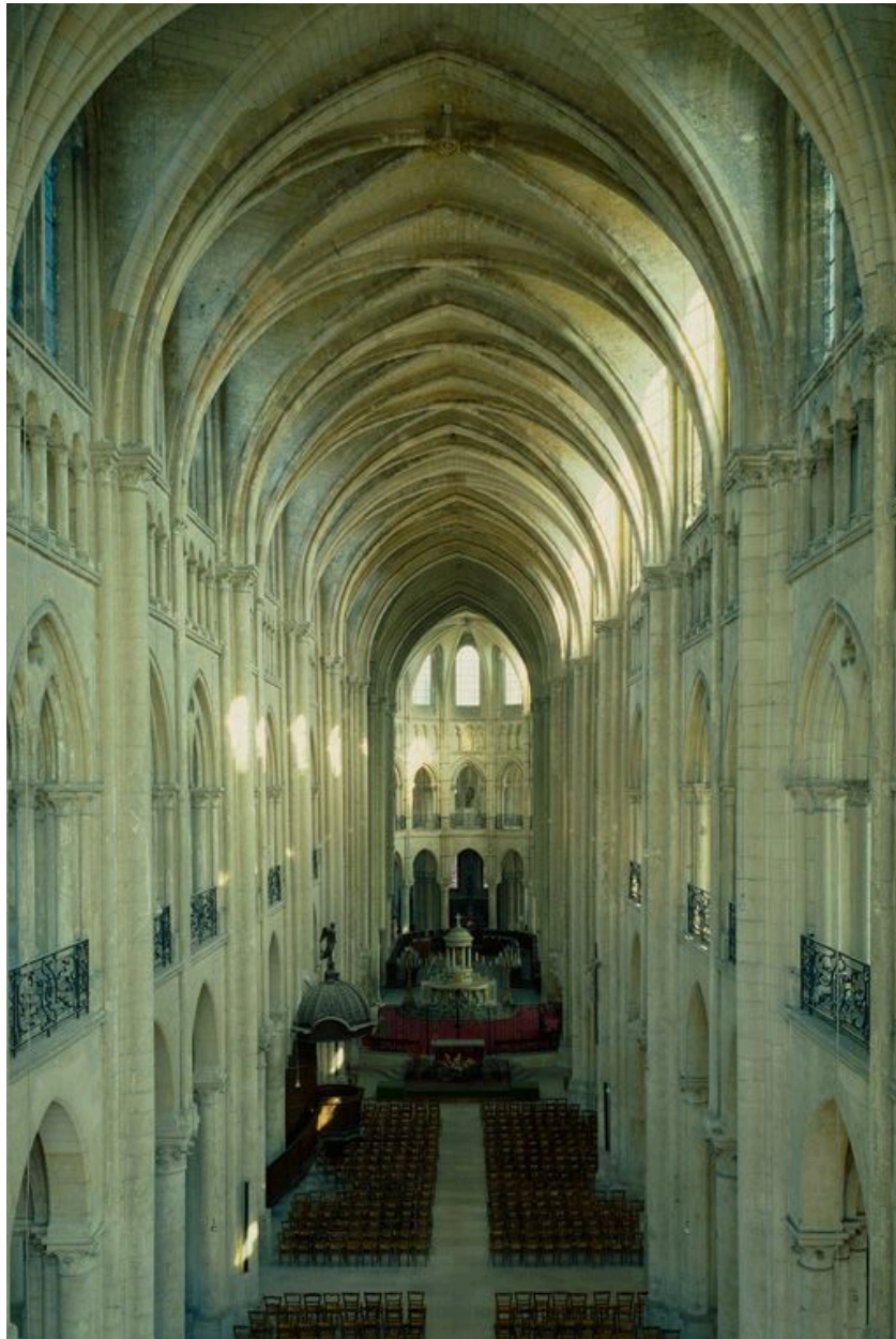
Vue intérieure de la nef, d'ouest en est.
