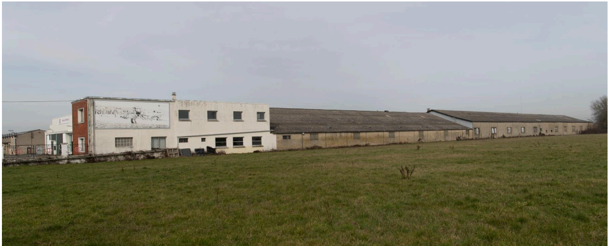
Usine Matrot, vue des anciens ateliers prise depuis l'est.
