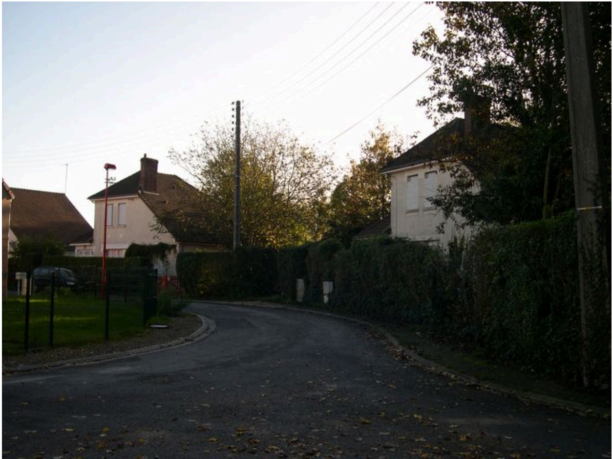
L'allée des Tilleuls, vue prise depuis le sud. Maisons à 1 logement de 6 pièces, 2 et 4 rue des Tilleuls.
