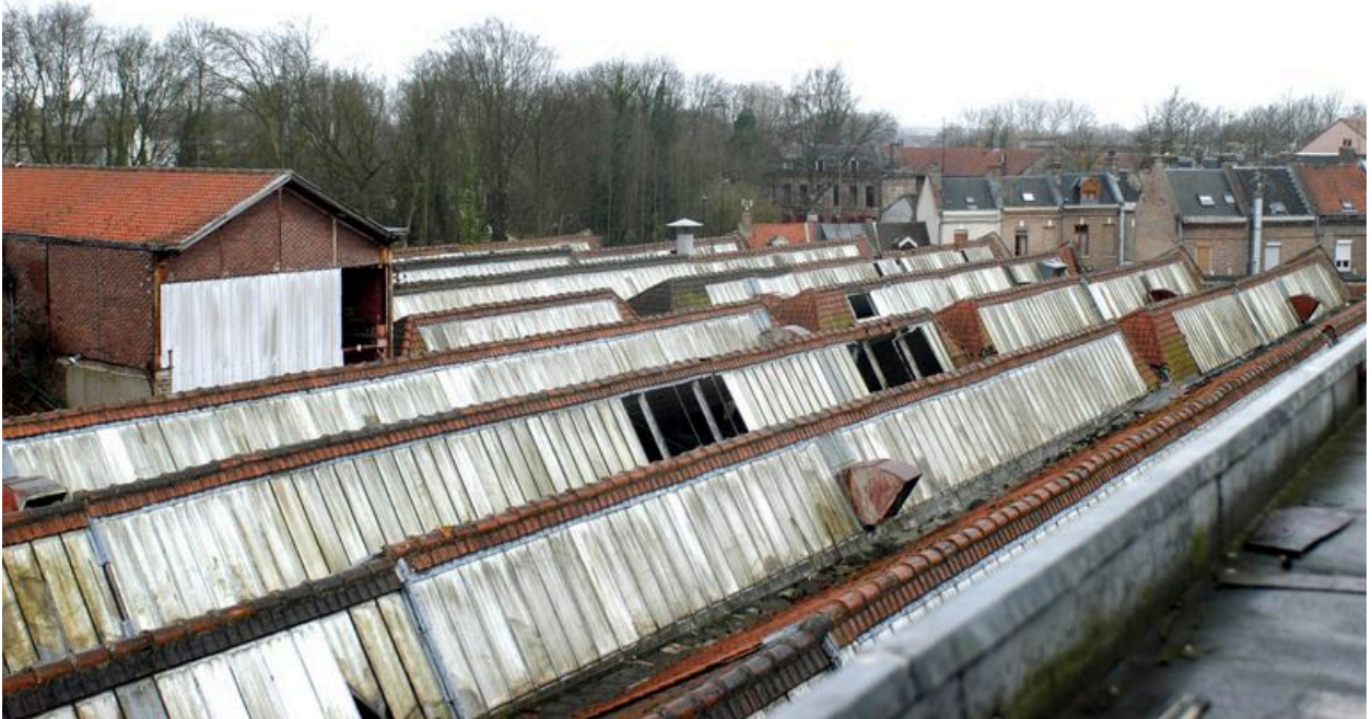
Vue des toitures.
