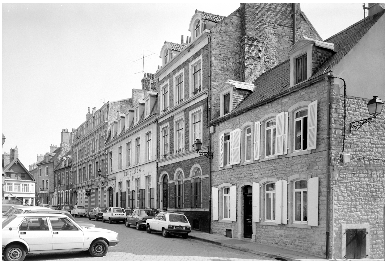
Façade sur voie.
