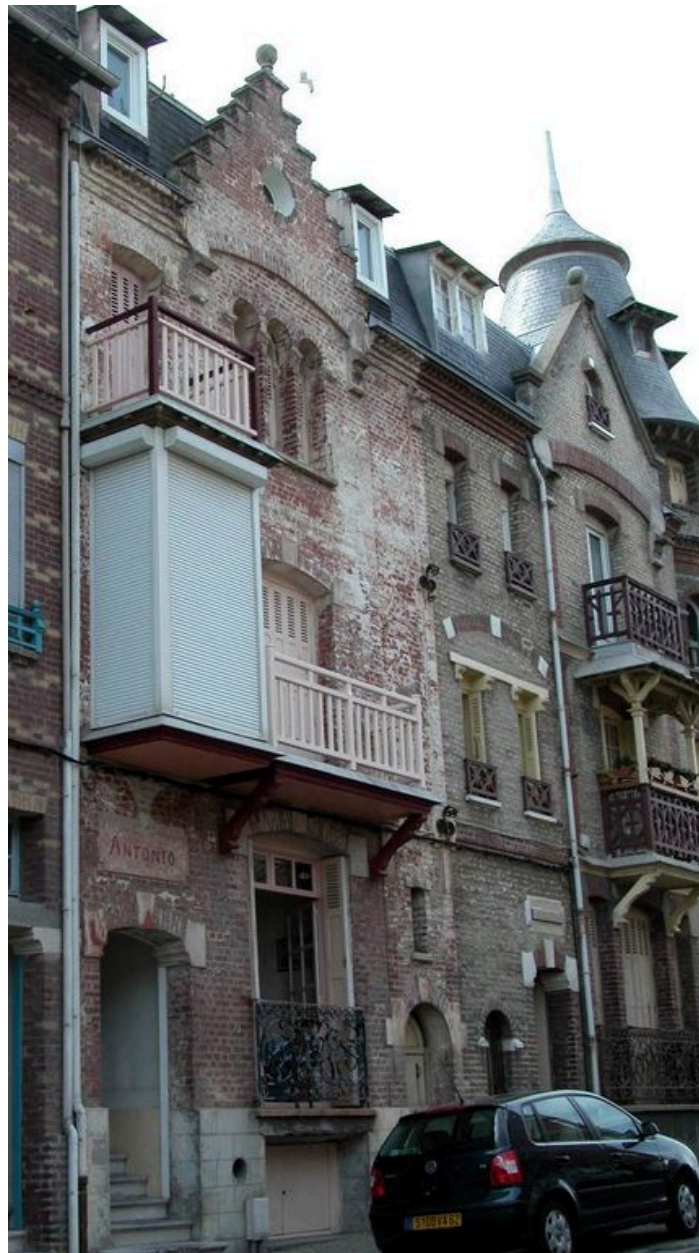
Vue du logement dit Antonio.
