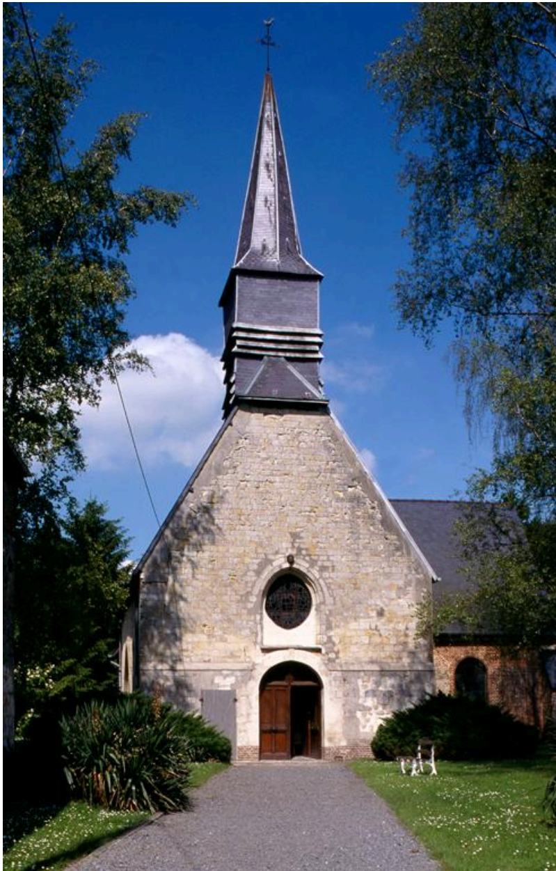
Vue générale de la façade de l'église priorale.
