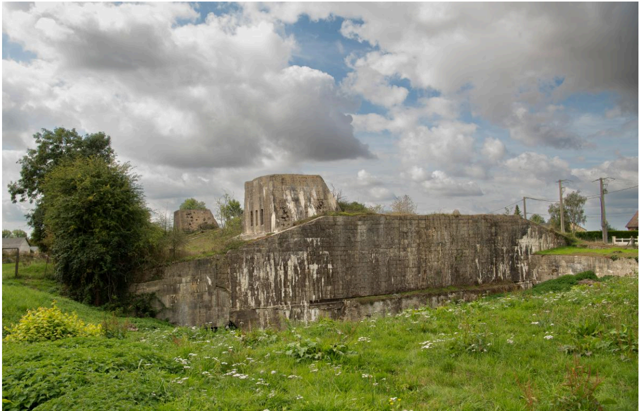
Elévation nord-est vue du sol, vers le nord.
