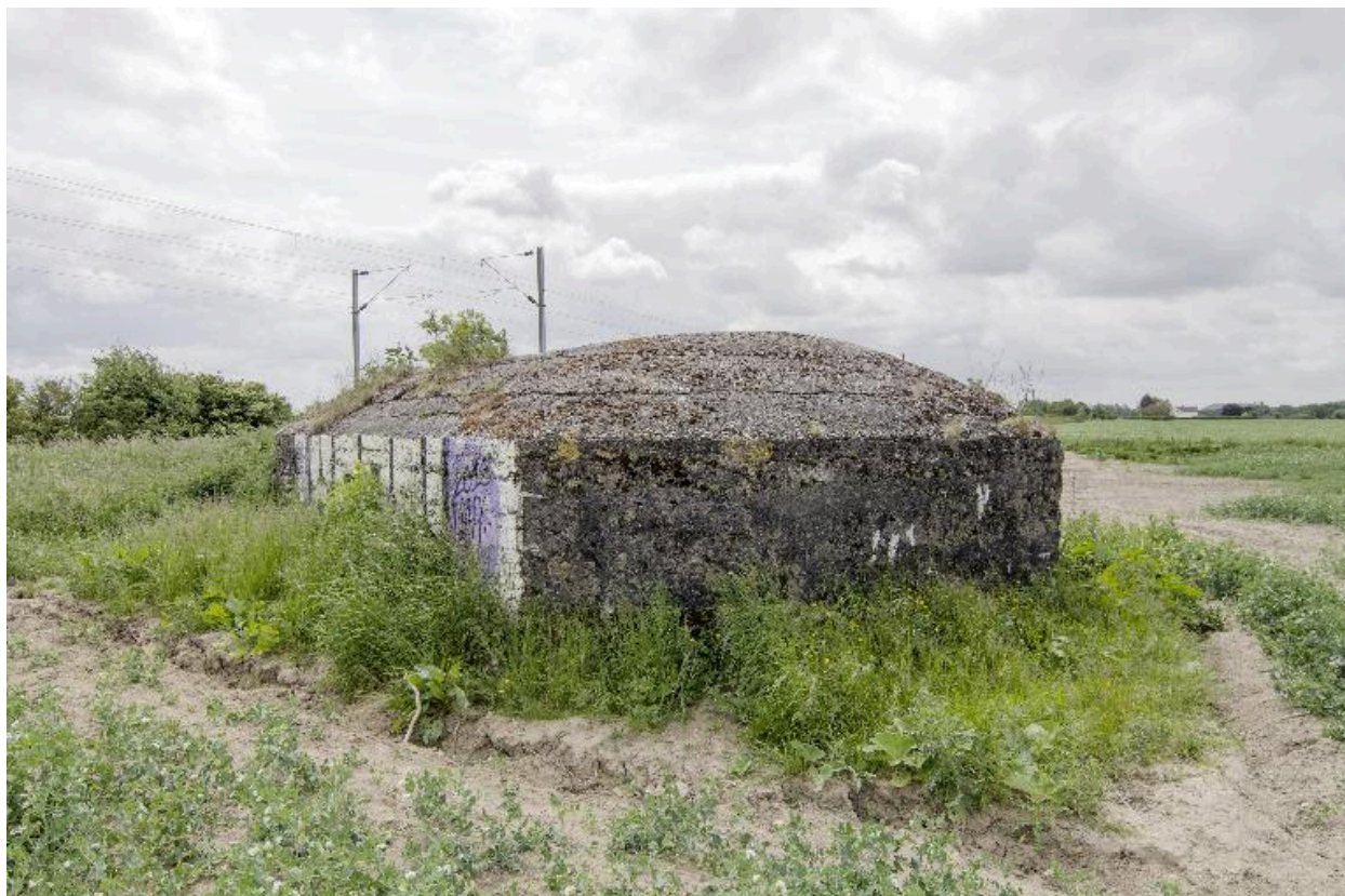
Vue de trois-quarts vers le sud-est
