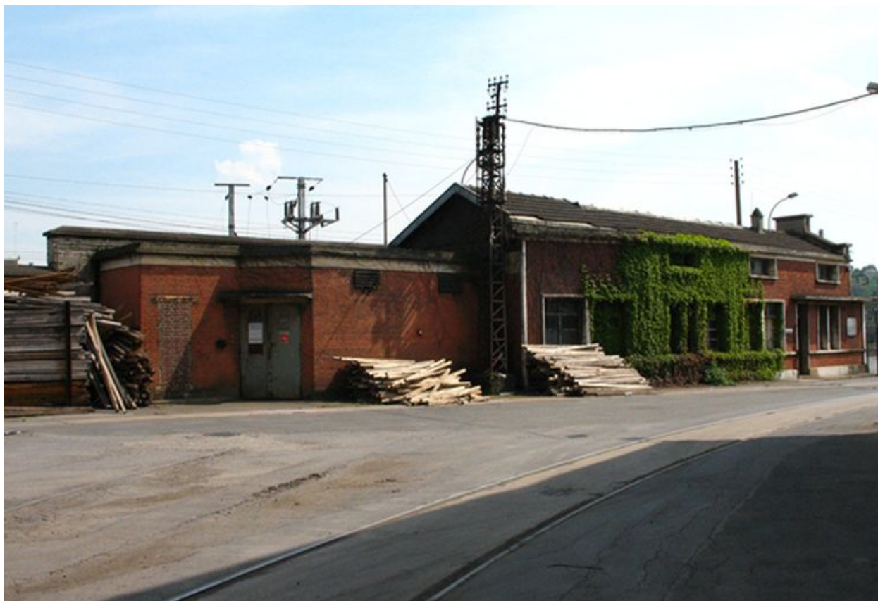
Transformateur électrique et bâtiment de la pointeuse.
