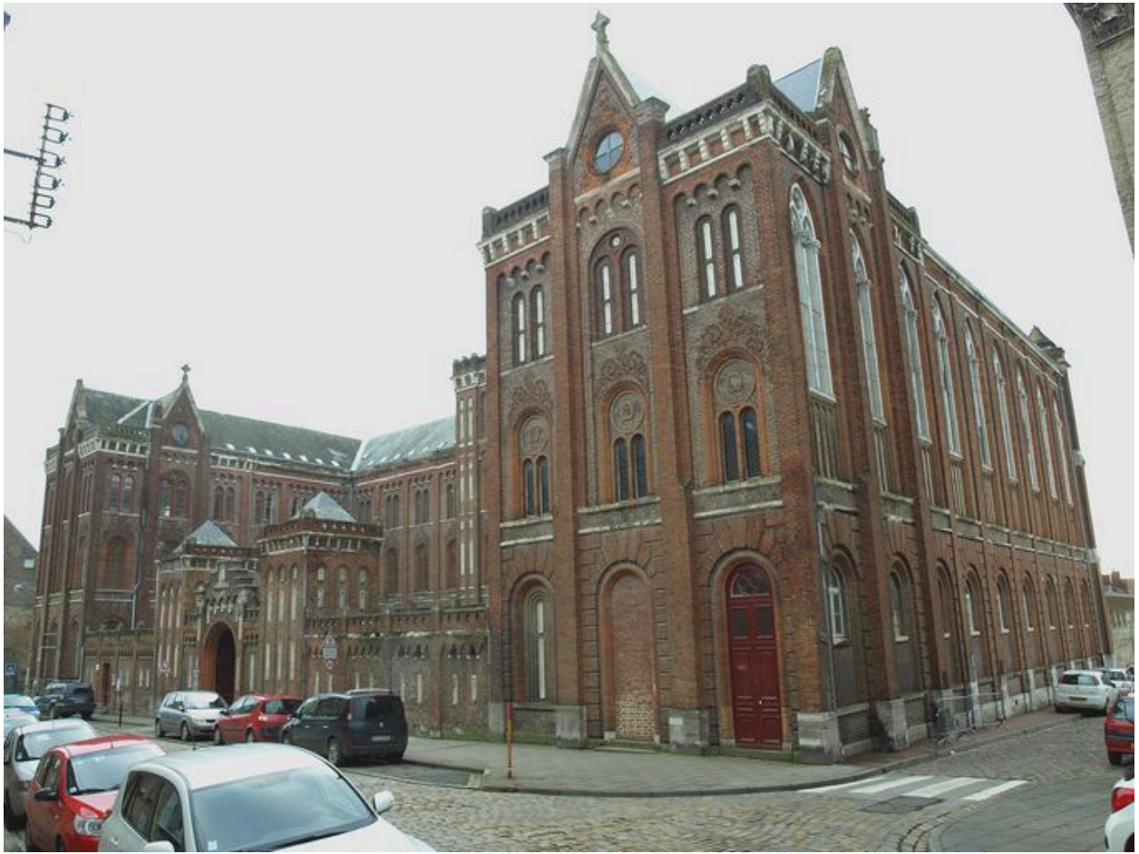
Façade sur rue : vue générale
