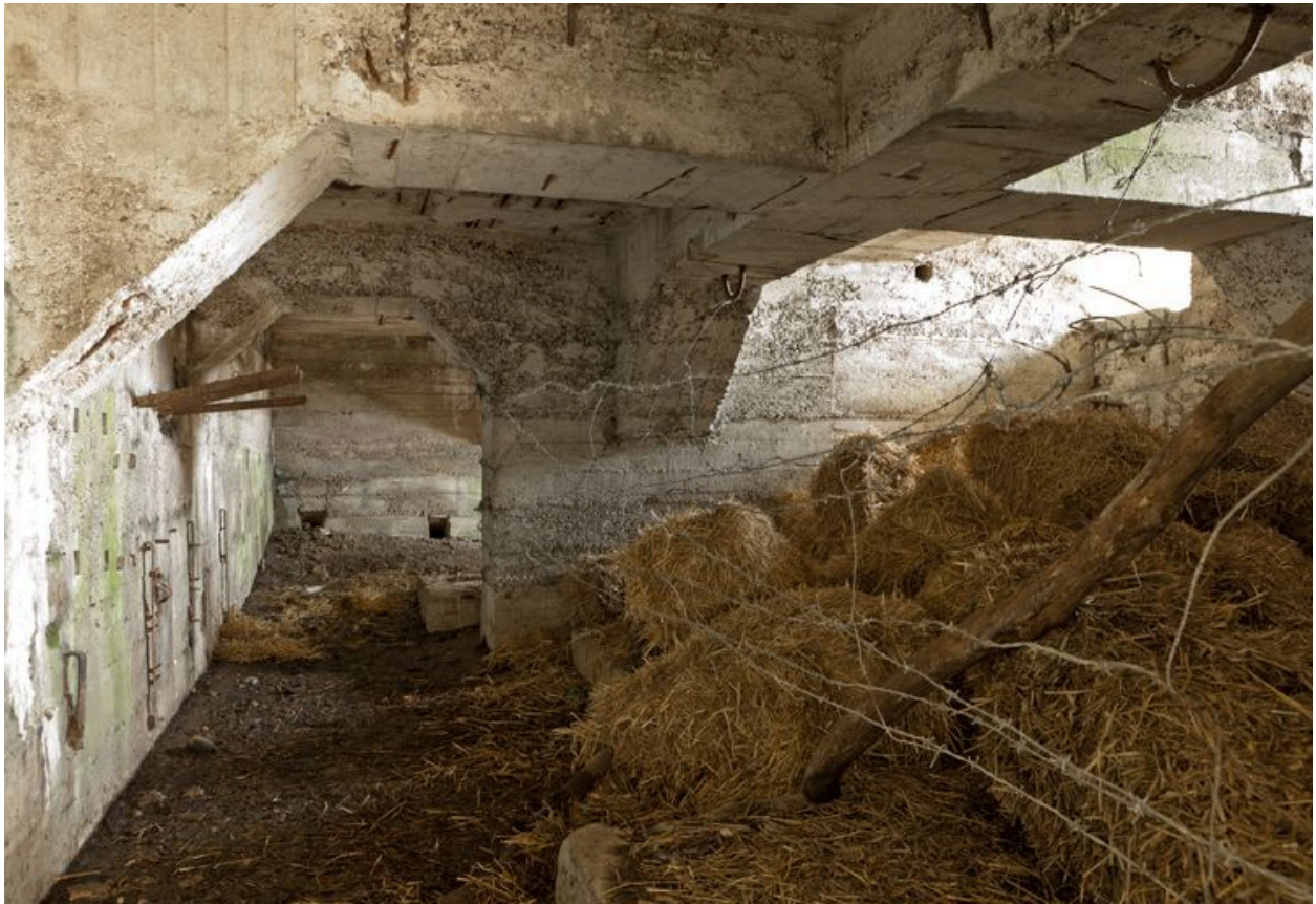
Vue intérieure, vers l'est
