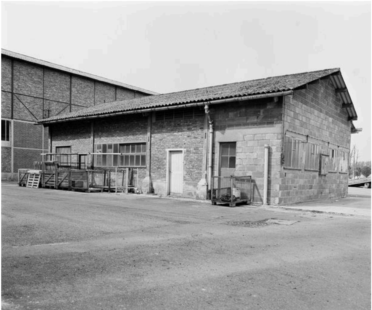
Atelier de réparation, angle nord est.
