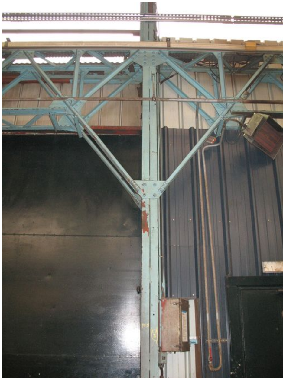
Détail de la poutrelle métallique et de la charpente.
