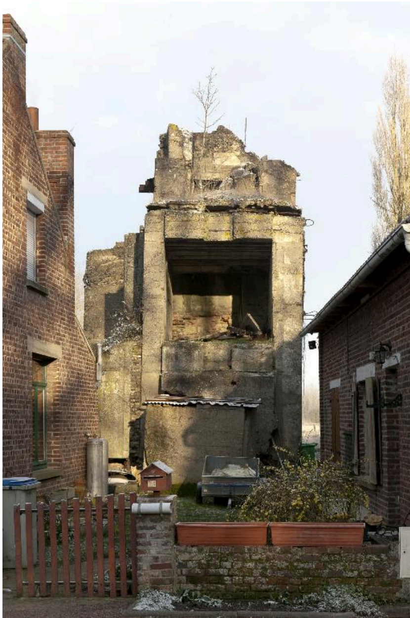
Vue vers le nord, depuis la rue Basse
