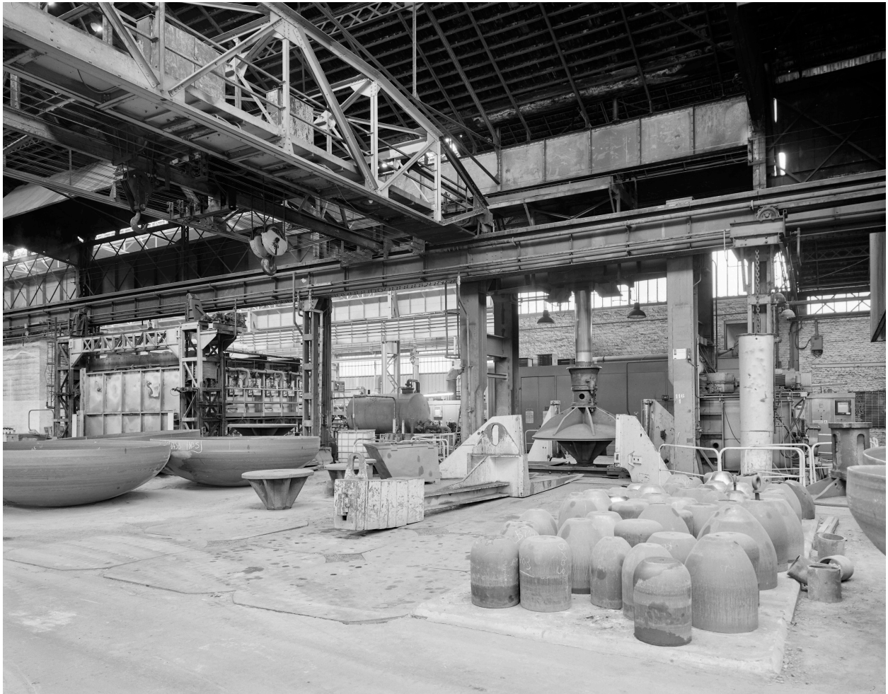
Hall 7 : vue générale de la machine à former et les galets (au premier plan).
