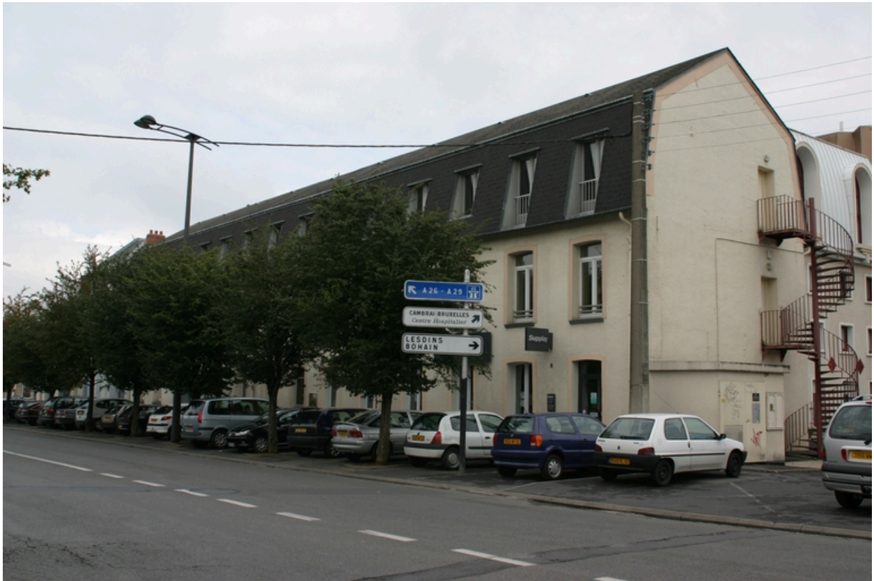
Façade antérieure de l'ancienne filature.
