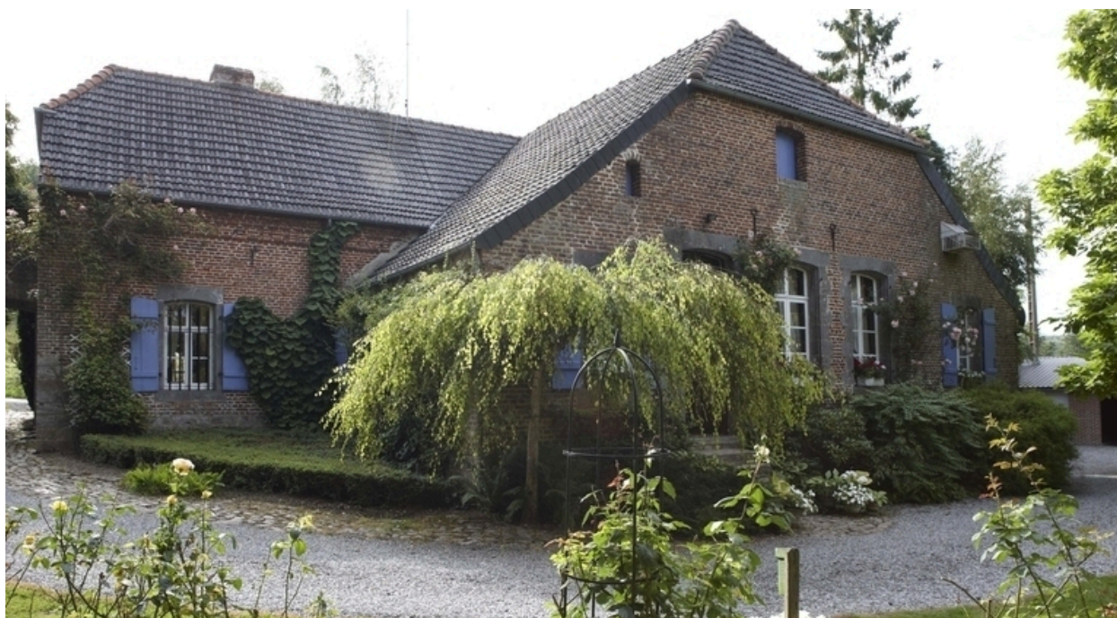
Vue de l'élévation sur cour.
