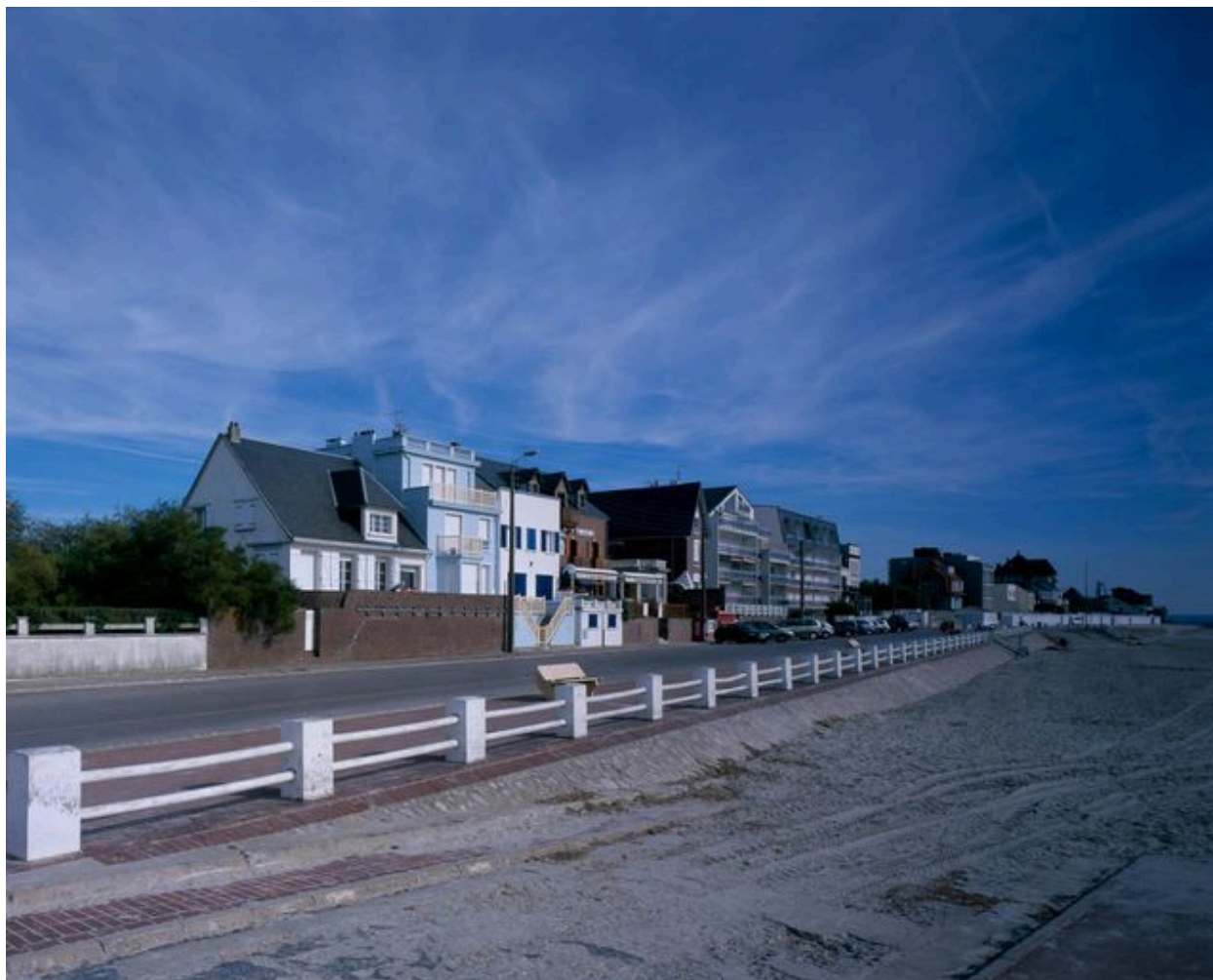
La digue Jules-Noiret, vers le sud-est.
