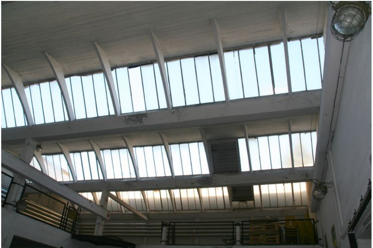
Vitrage des sheds.
