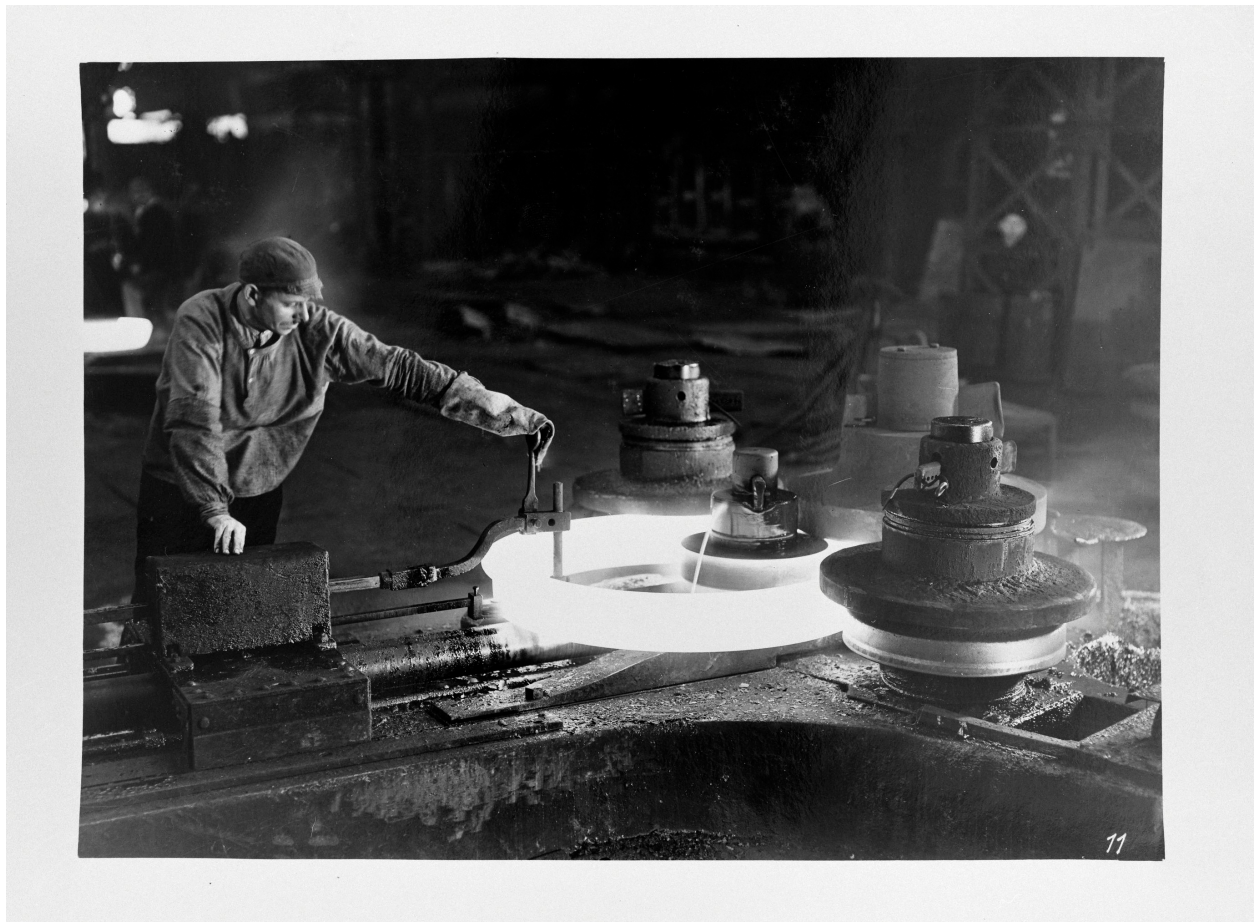
Laminoir à bandages : le contrôle du diamètre. Photographie ancienne, auteur inconnu, sans date (coll. part.).
