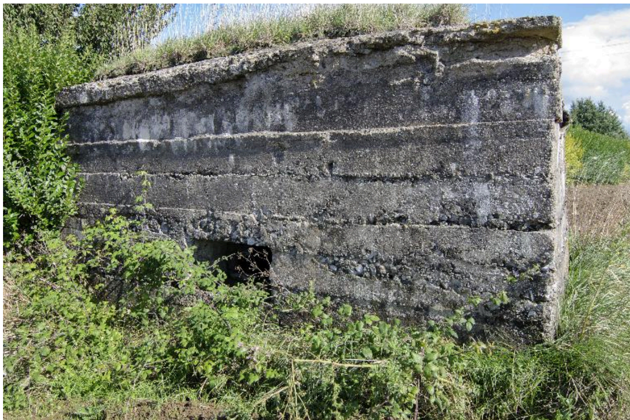
Sortie du canon, élévation nord-ouest
