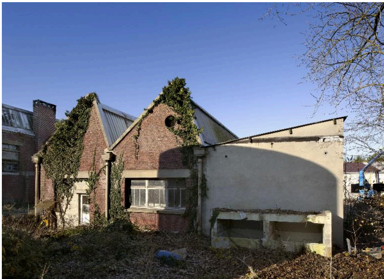
L'atelier de menuiserie, façade sud.
