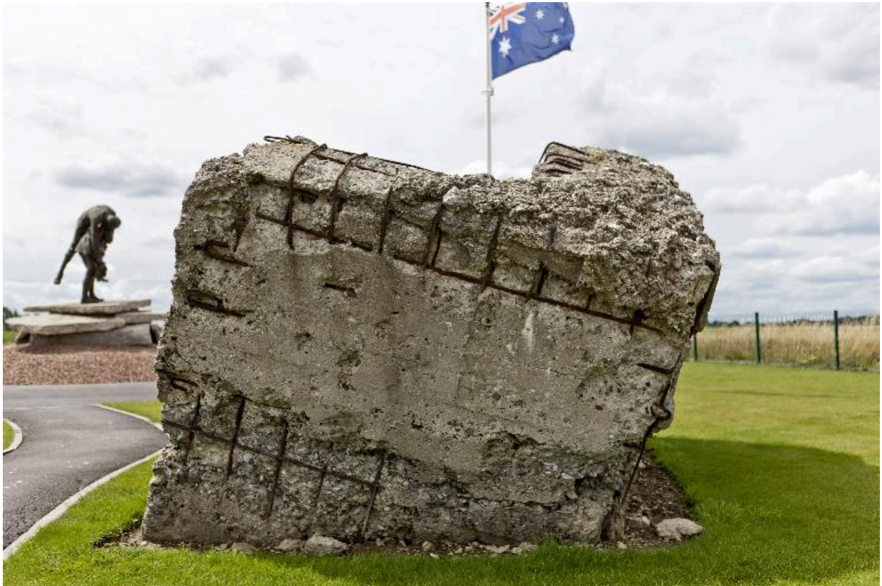
Vestiges de la casemate (e) retournée lors de l'explosion d'une mine, vers le le sud-ouest
