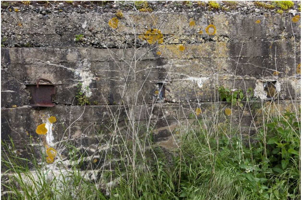
Vue latérale, vers le sud-ouest. Sortie des poutrelles en I soutenant la dalle.
