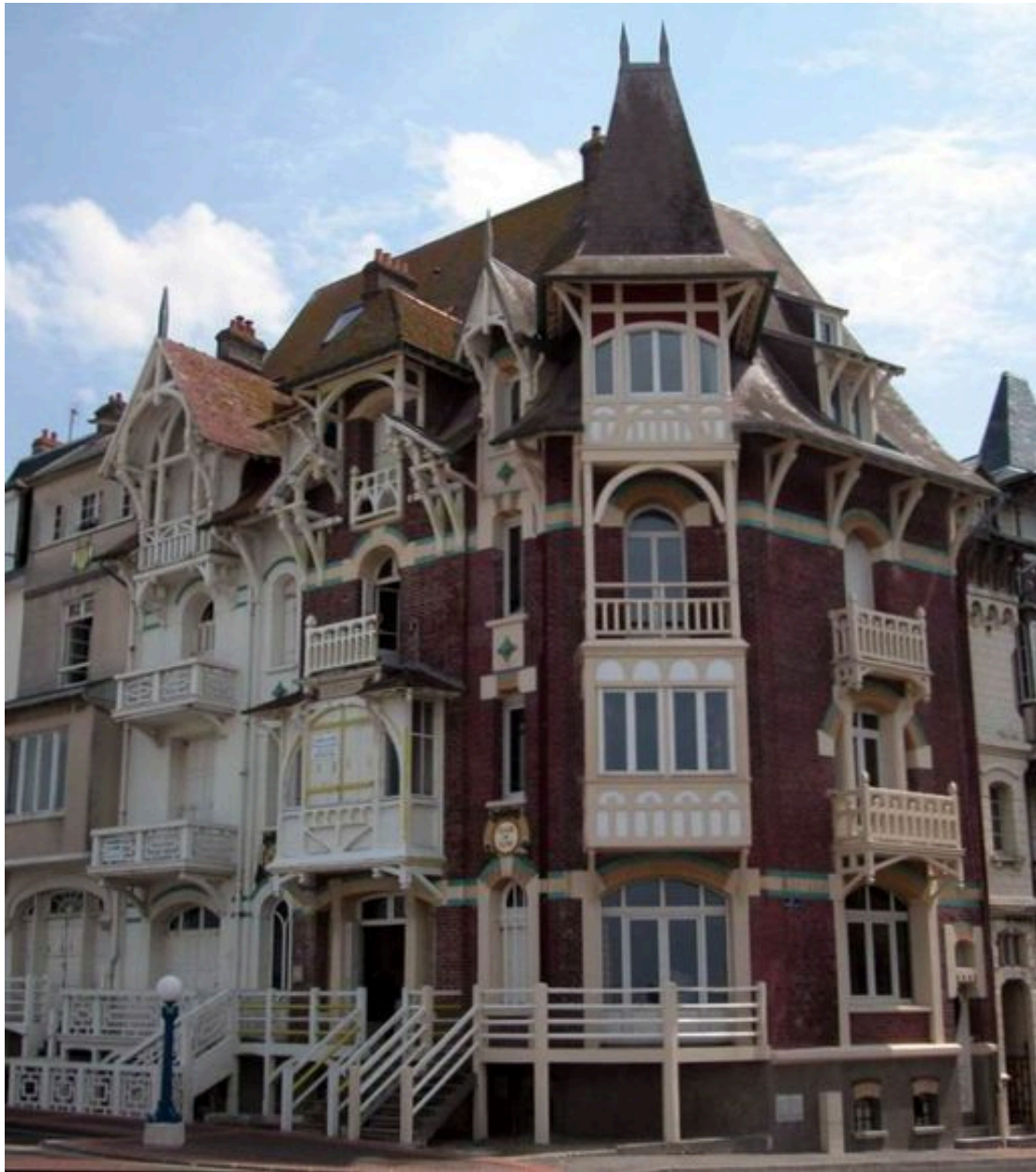
Vue d'ensemble depuis l'esplanade.
