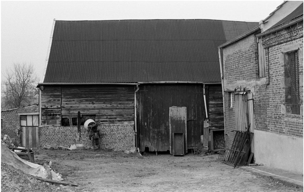
Élévation sur cour de la grange.
