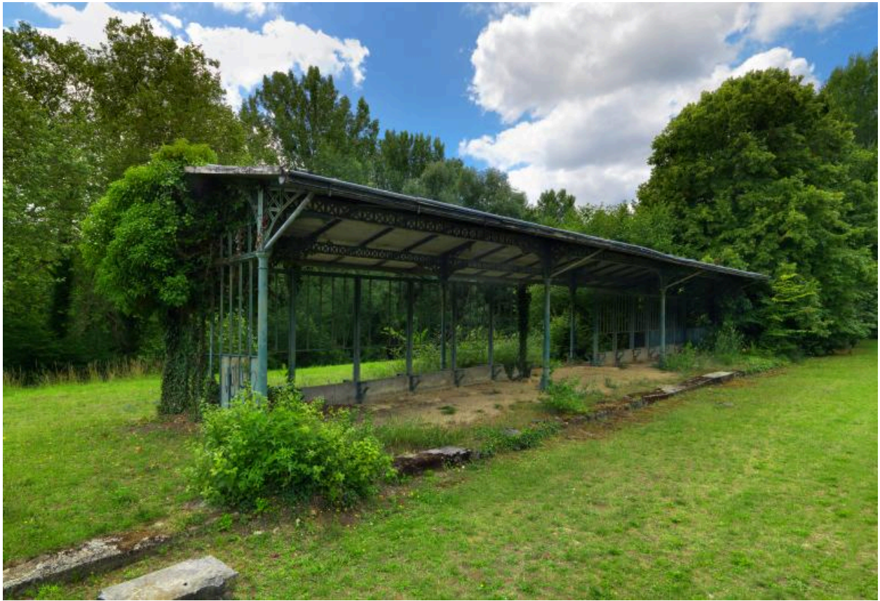
Marquise de l'abri des voyageurs sur le quai central entre l'emprise des anciennes voies.
