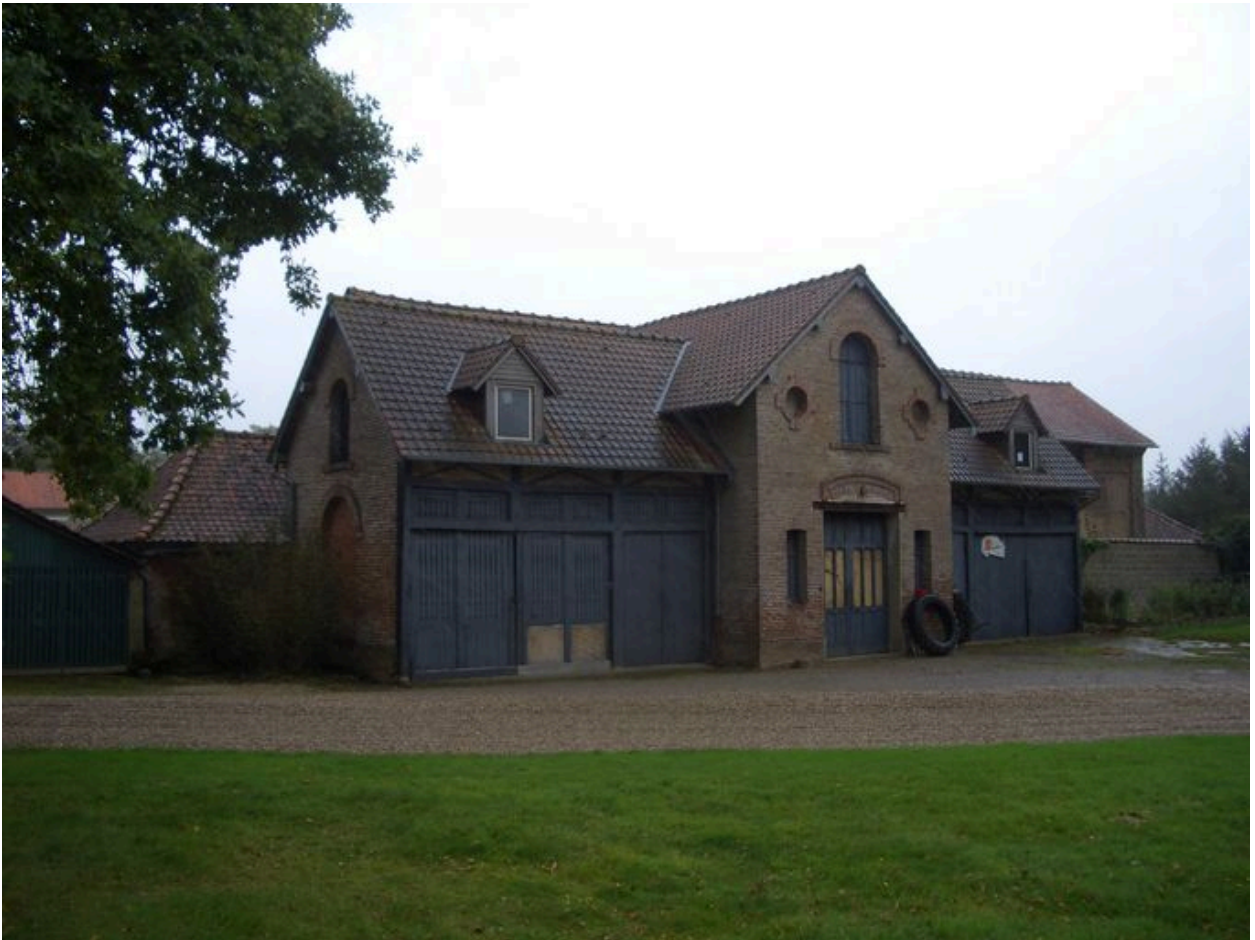
Vue des dépendances du château.
