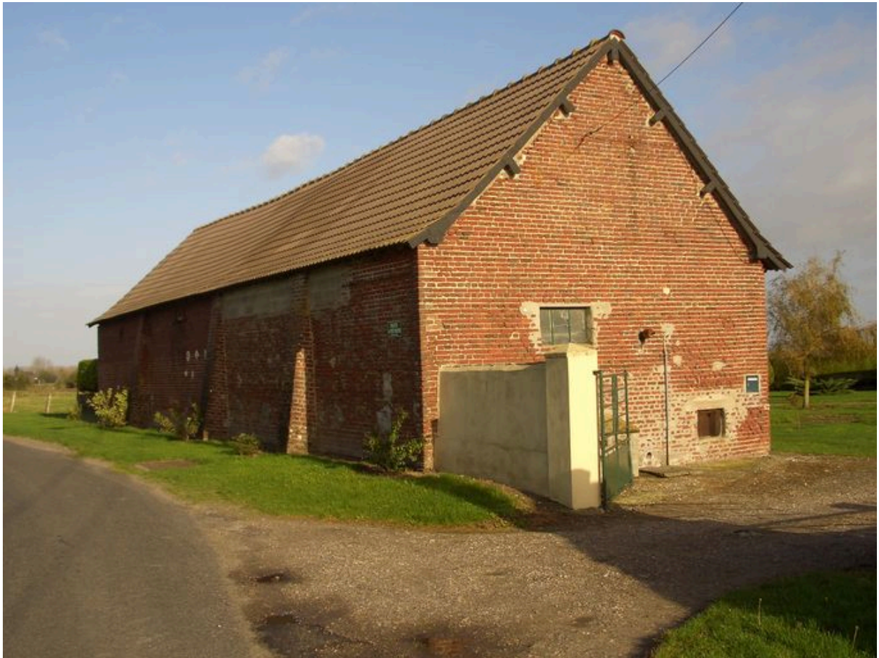
Vue de la grange sur rue.
