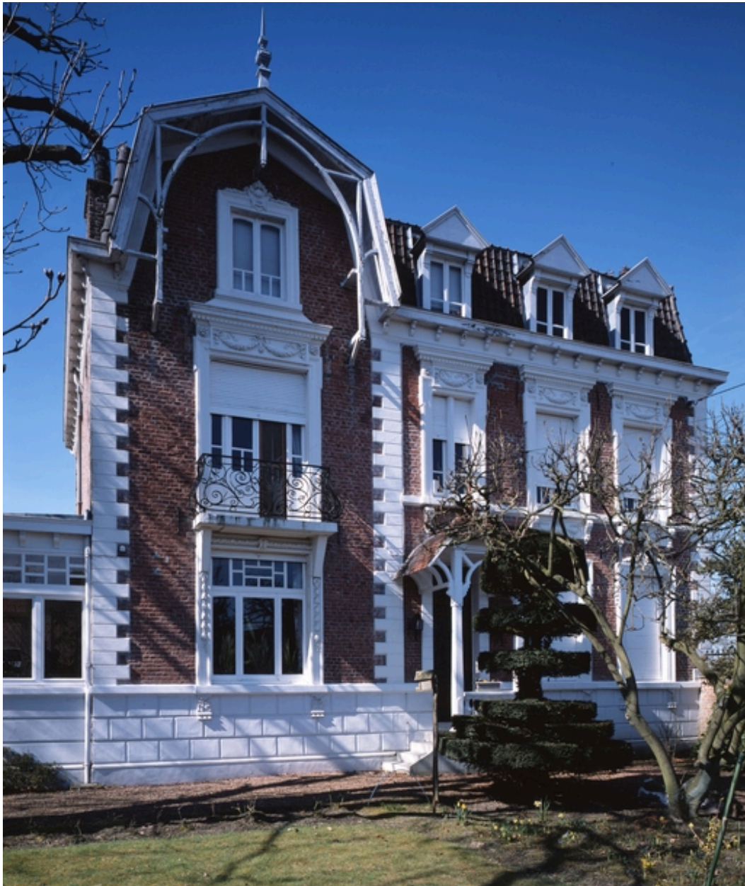
Maison bourgeoise située 163, rue Delannoy, vue générale.
