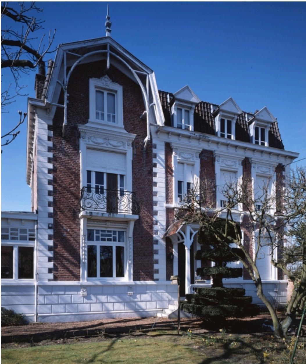
Maison bourgeoise située 163, rue Delannoy, vue générale.
