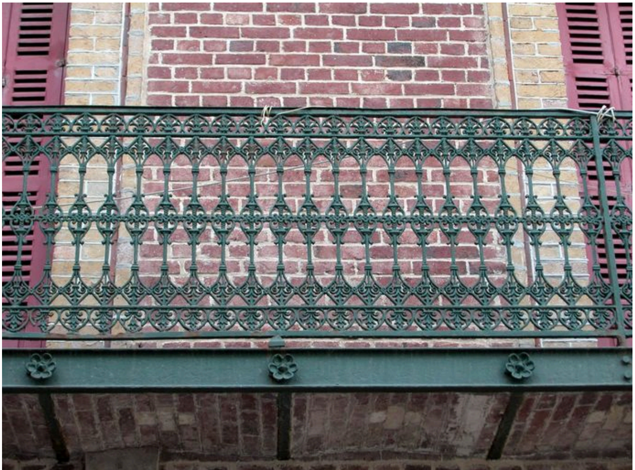
Détail d'un garde-corps en fonderie.
