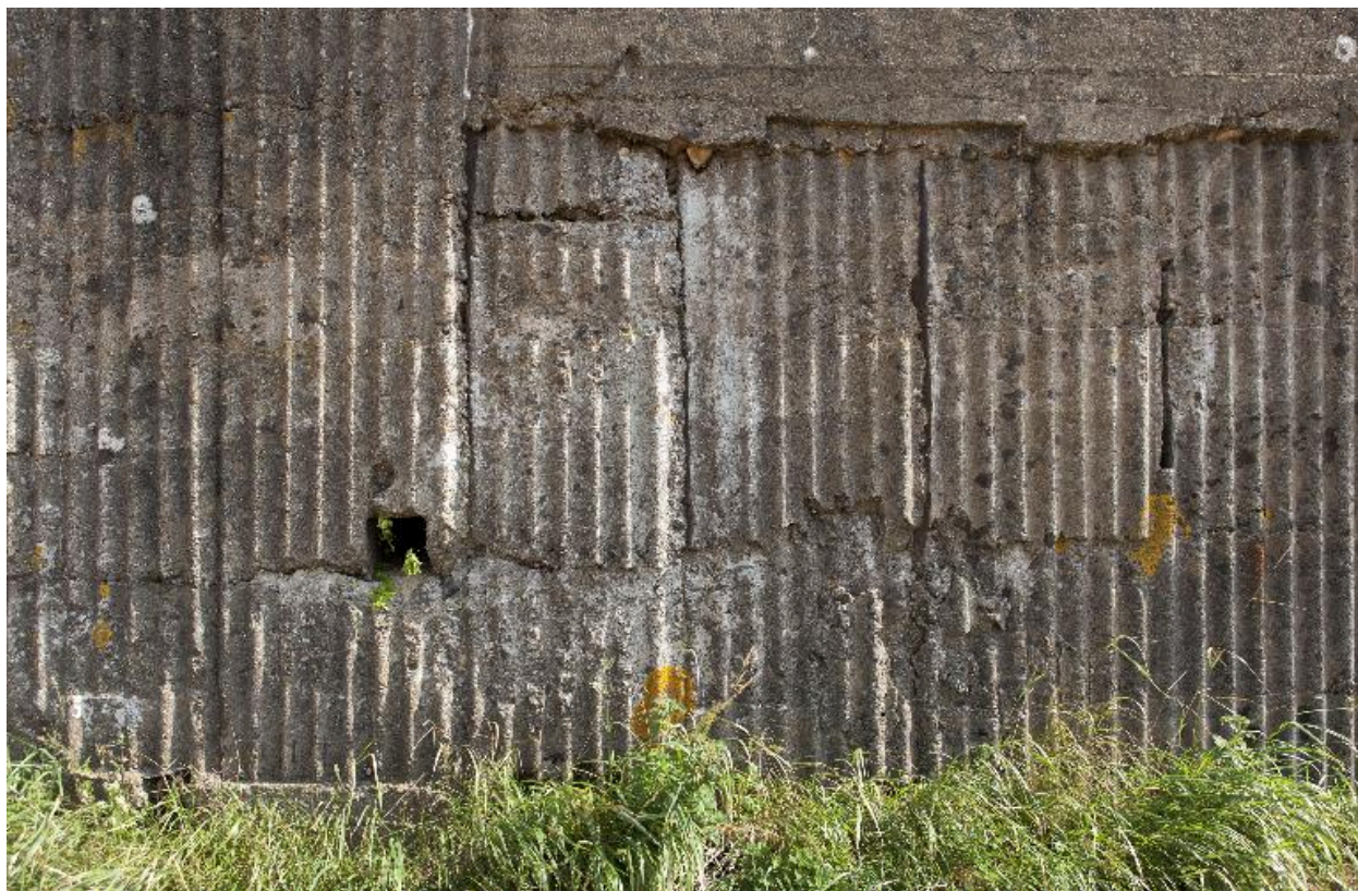
Élévation sud-ouest, détail du coffrage et créneau de fusillade
