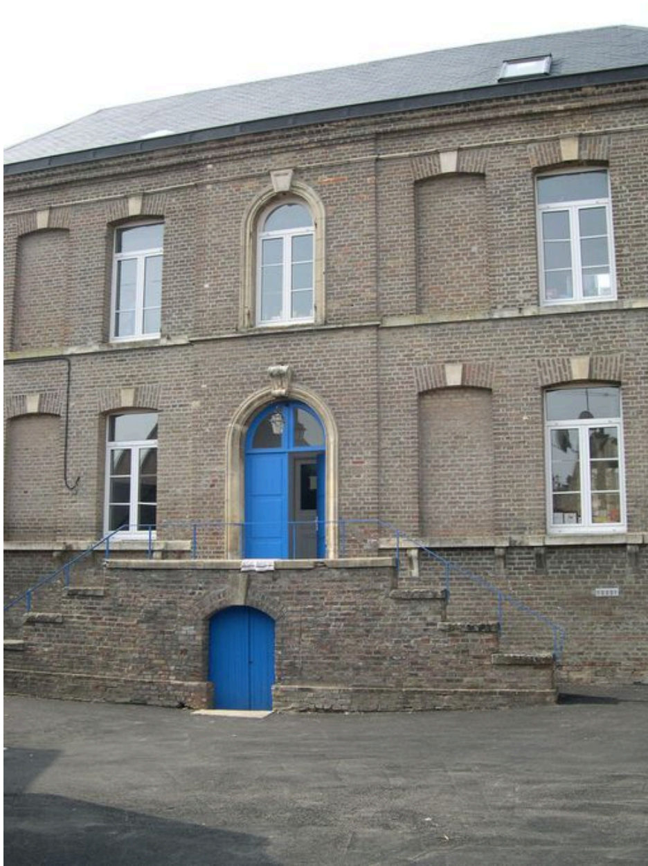
Le presbytère. Détail de la façade est, sur cour.
