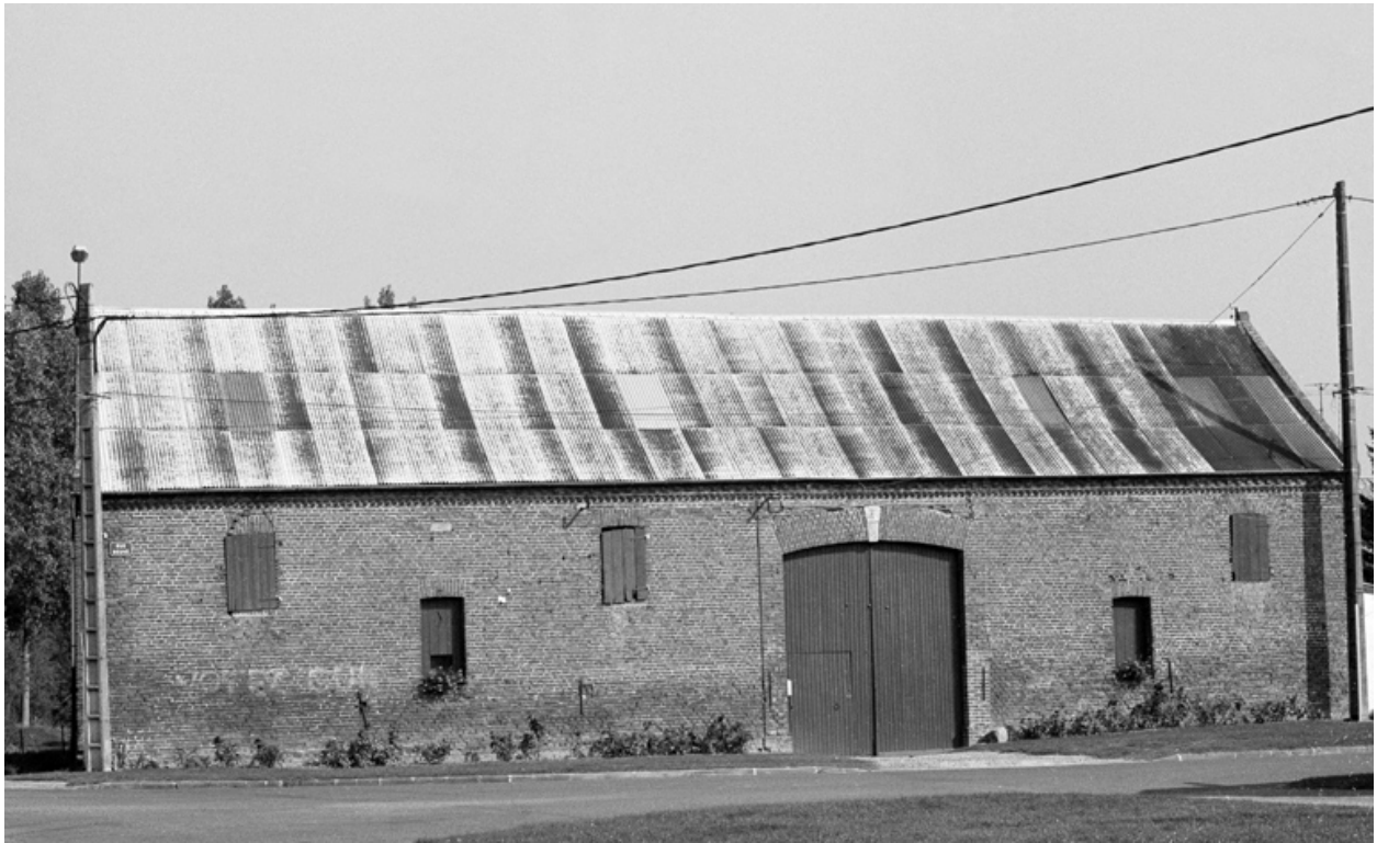
Vue de la grange en briques qui clôt la cour de ferme sur la rue (1858).
