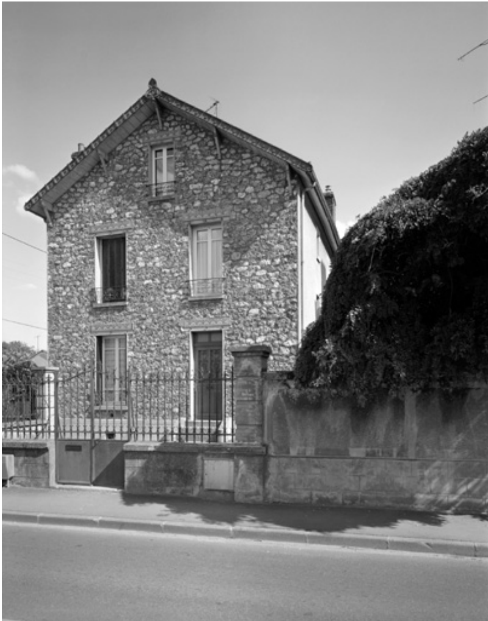
Maison, 20 avenue d'Essômes. Vue depuis la rue.
