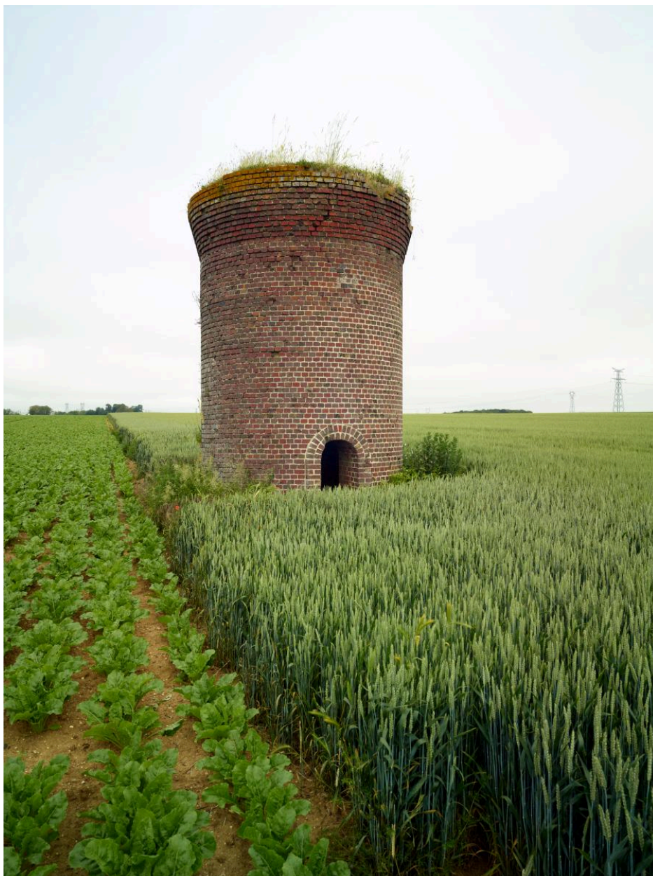
Vestige d'un four à chaux utilisé pour la construction du canal du Nord. À proximité du site écluse n°16 de Campagne (Oise).
